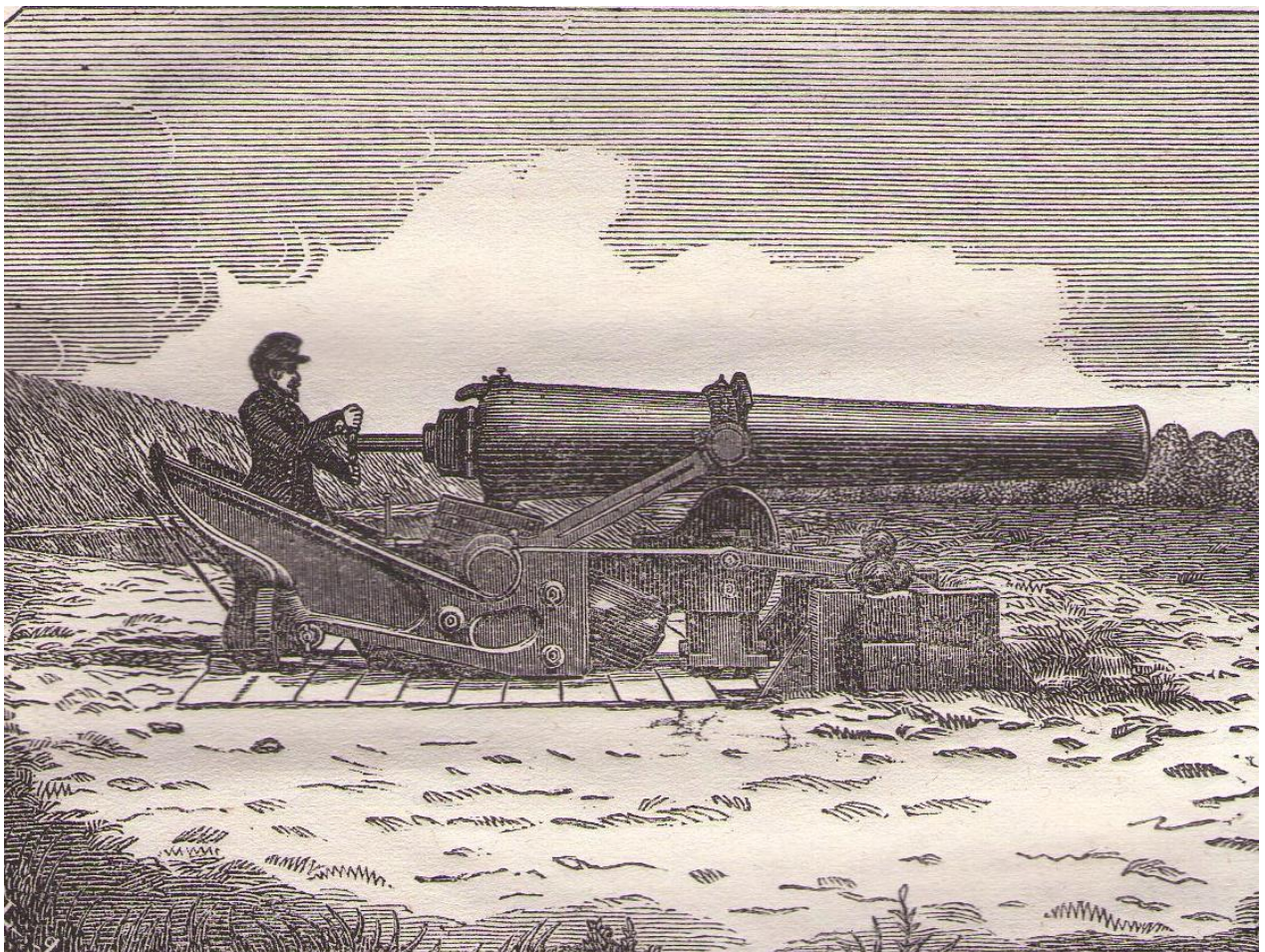
Bilden visar Engströms 24-pundiga kammarladdningskanon under provskjutning i Vincennes 1857
